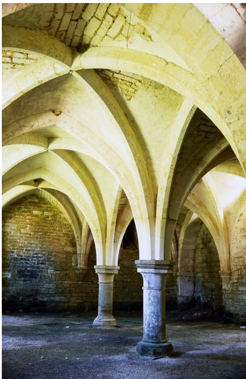
Le cellier, salle voûtée en soubassement.
