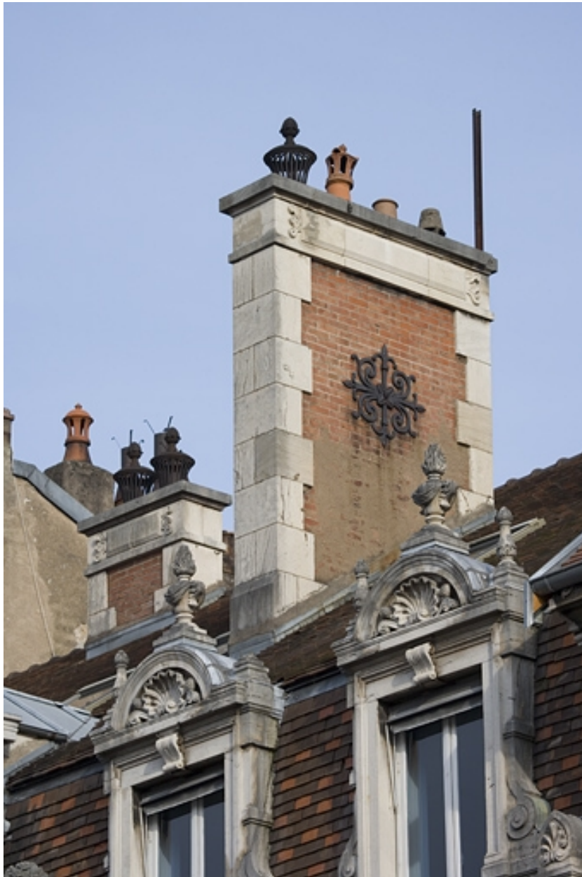
Détail d'une souche de cheminée.
