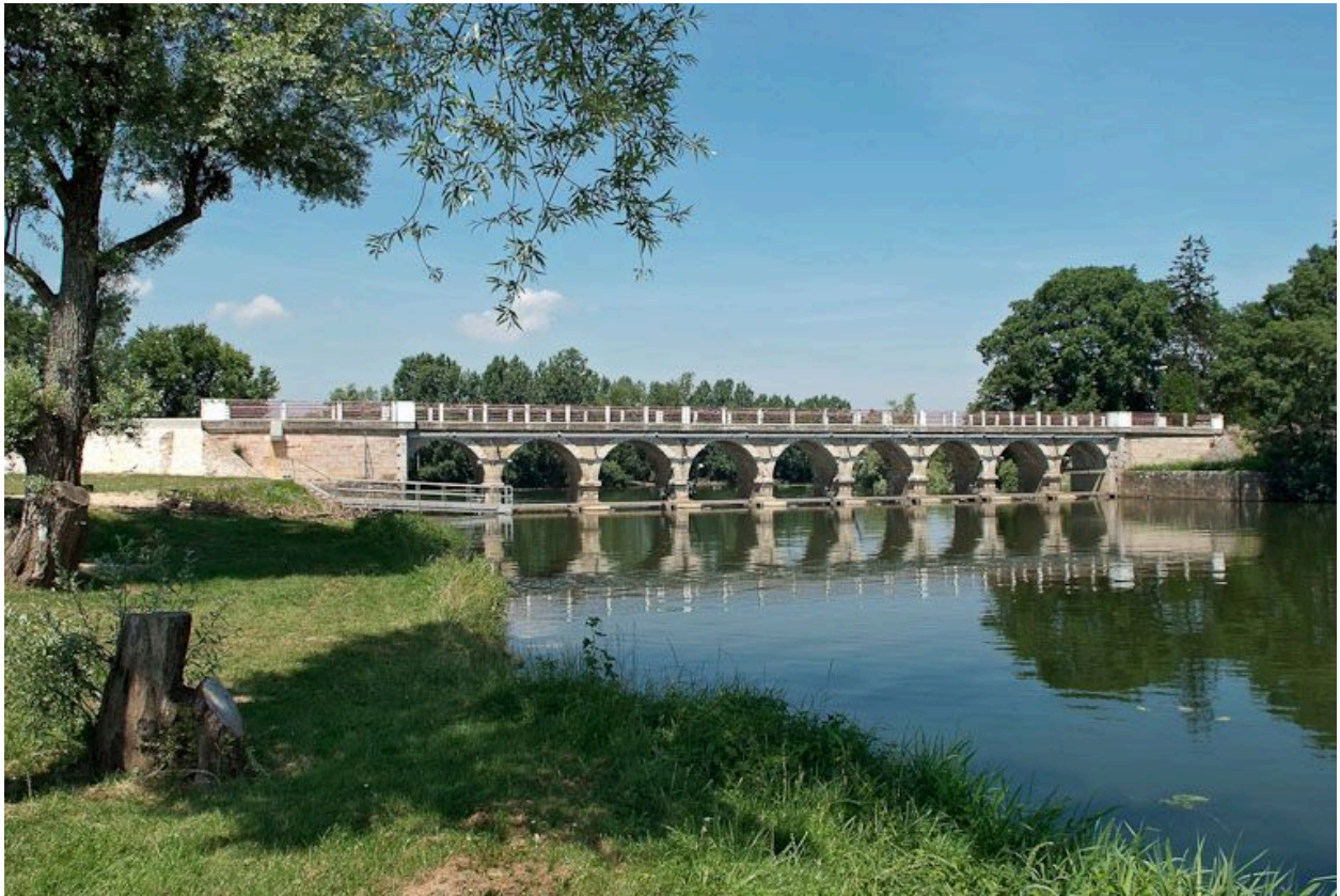
Barrage et pont de La Truchère, vue d'ensemble, de la rive gauche de la Seille.
