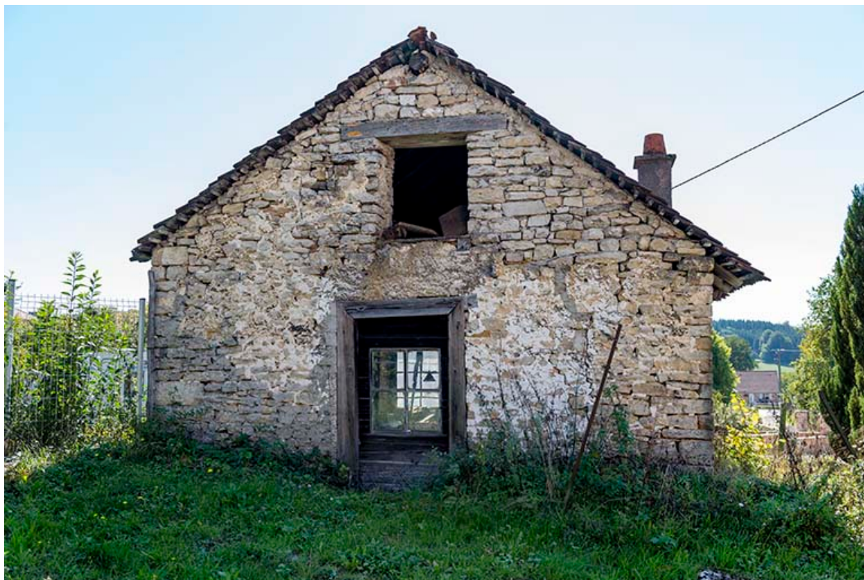
Forge : façade antérieure.
