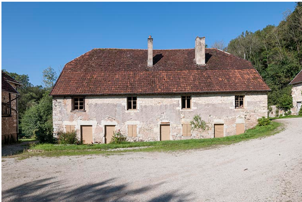
Logement d'ouvriers. Façade est.
