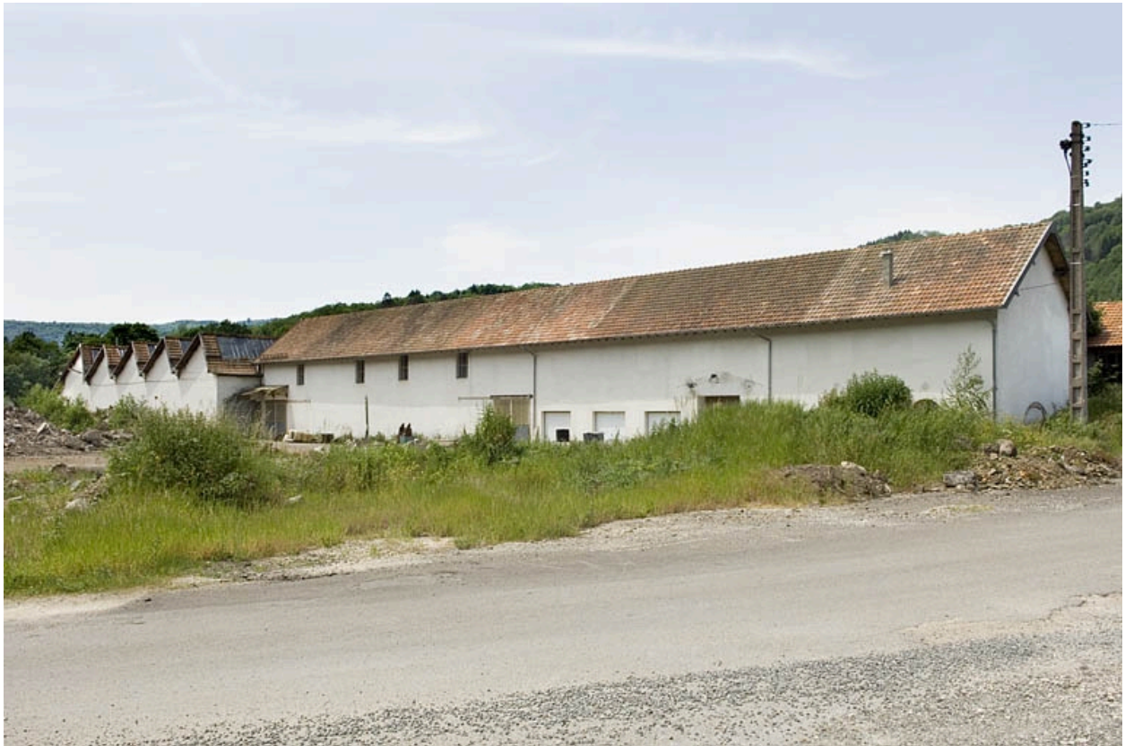
Atelier de fabrication (boulonnerie) depuis l'est.
