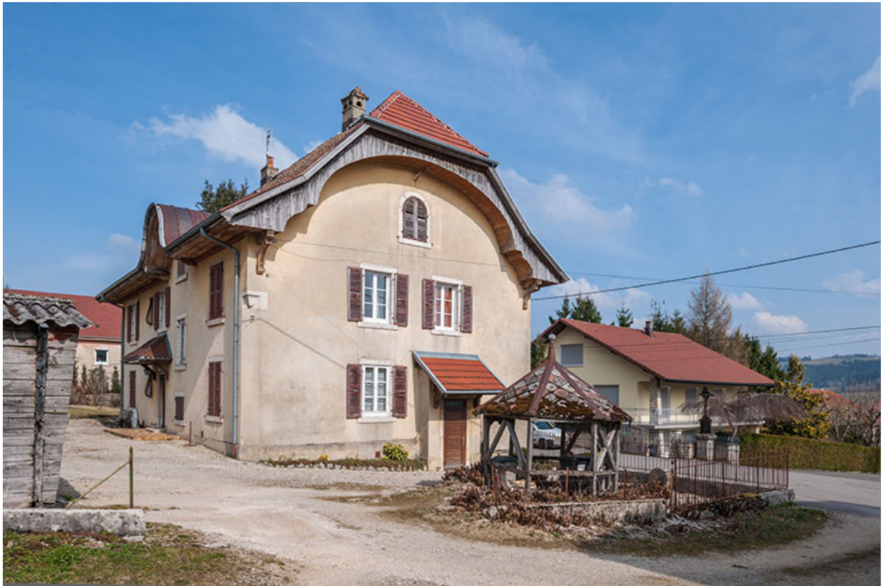
Logement patronal : façades postérieure et latérale gauche.
