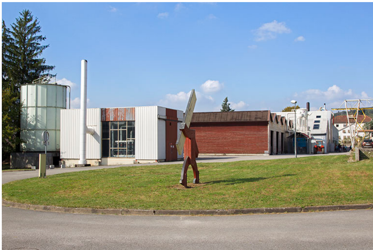
Dépôt de bois et atelier.
