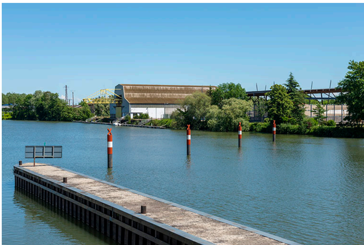
Digue de l'entrée de l'écluse sur la gauche.
