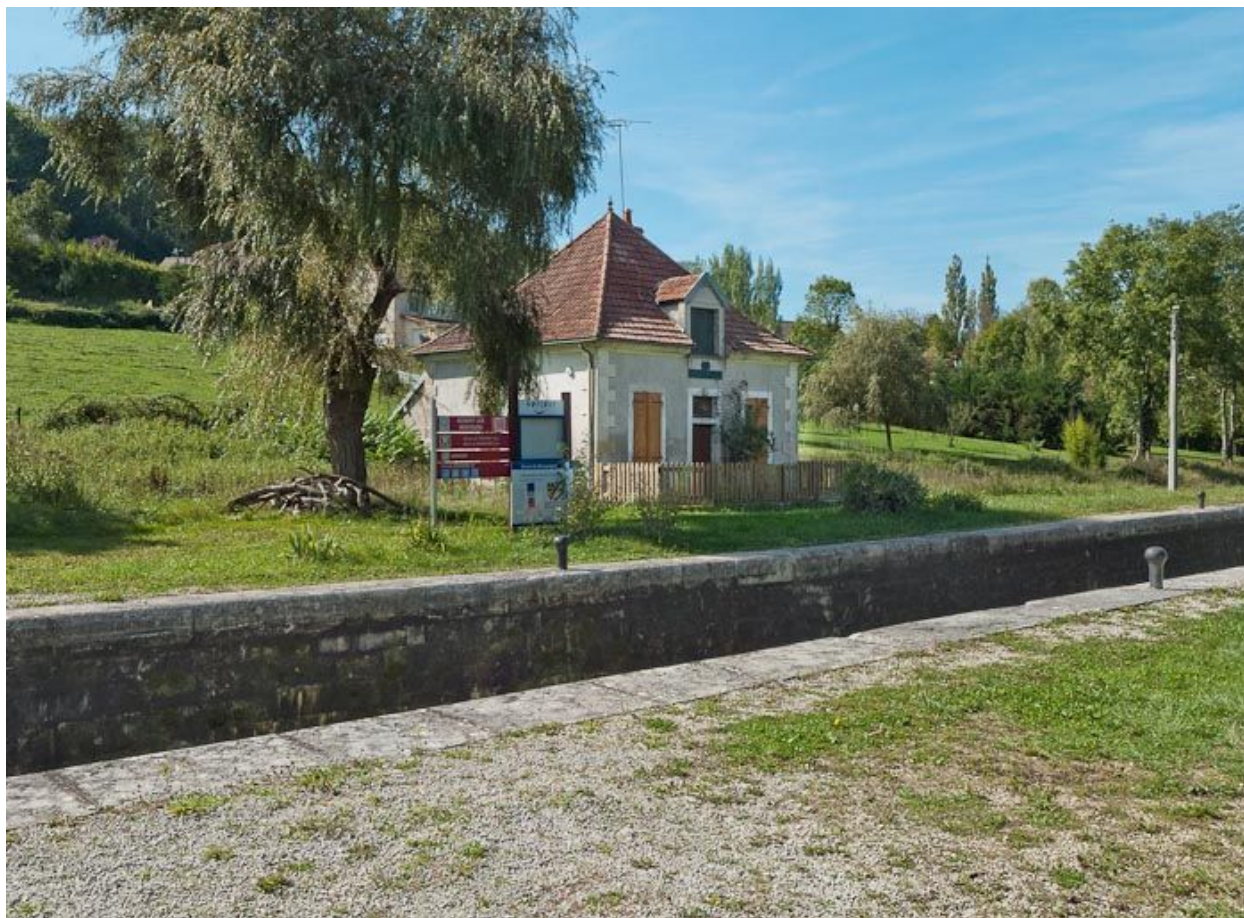
Vue d'ensemble du site d'écluse.
