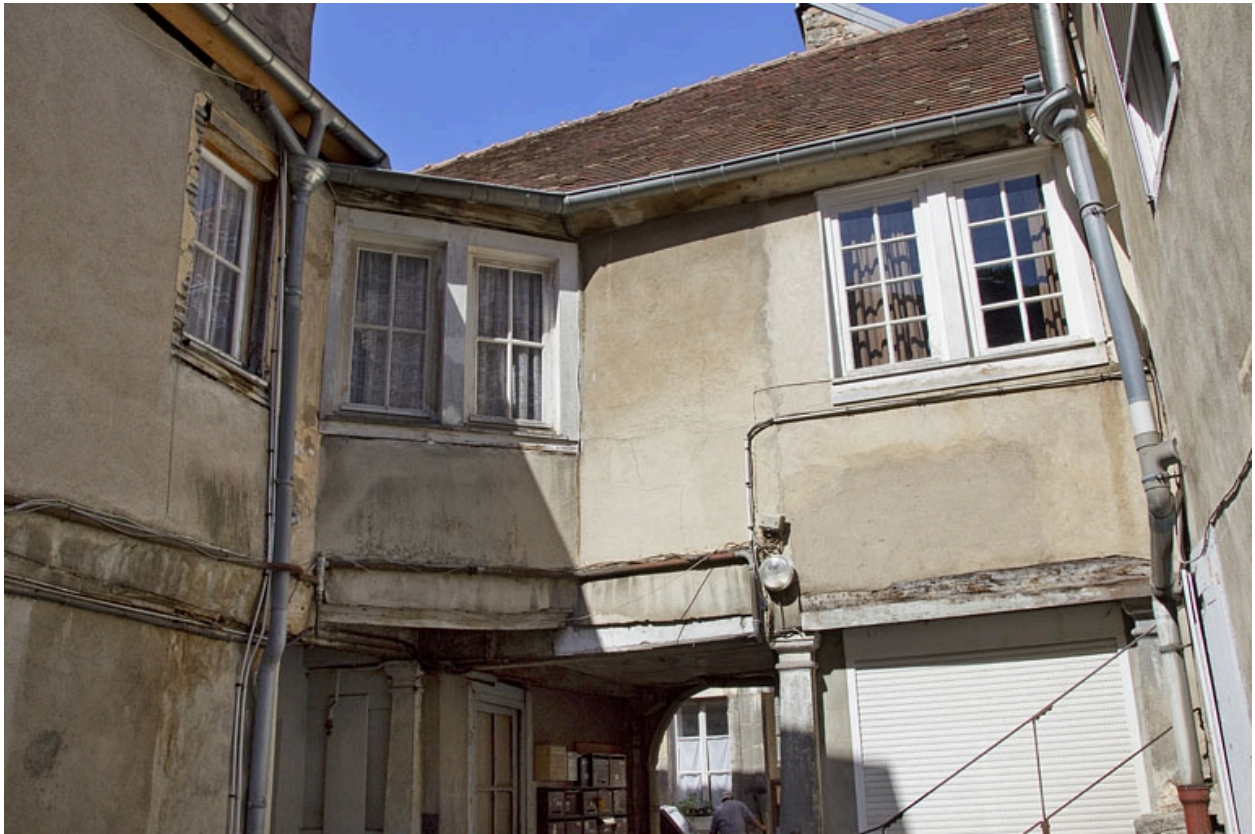
Façade postérieure du premier logis secondaire : vue d'ensemble.
