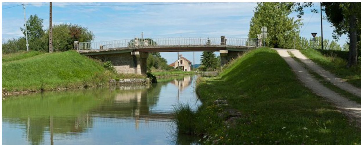
Vue du pont depuis l'aval.
