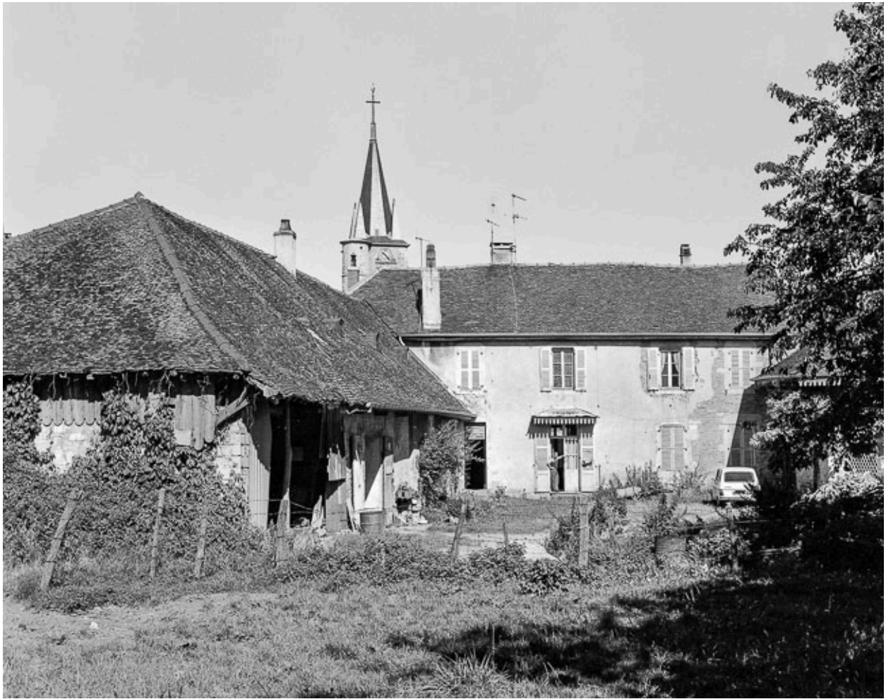
Maison cadastrée AC 251 : façade antérieure.
