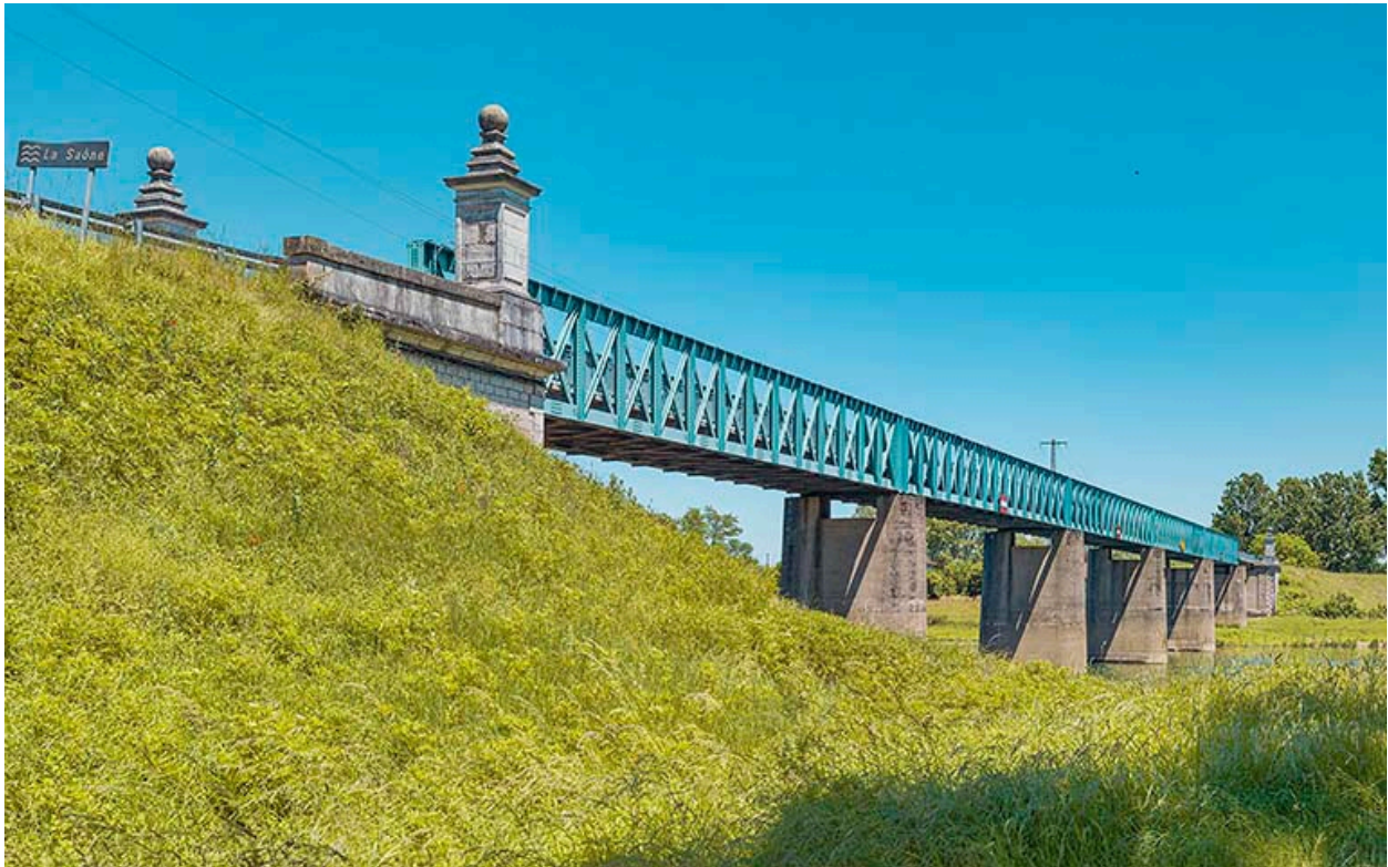
Vue d'ensemble du pont.
