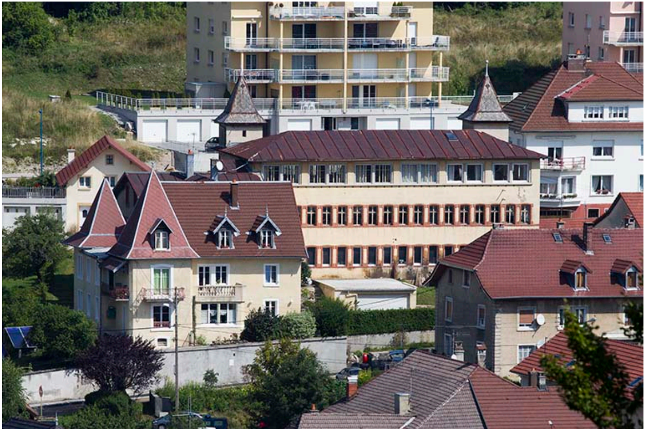
Vue d'ensemble plongeante, depuis le sud.
