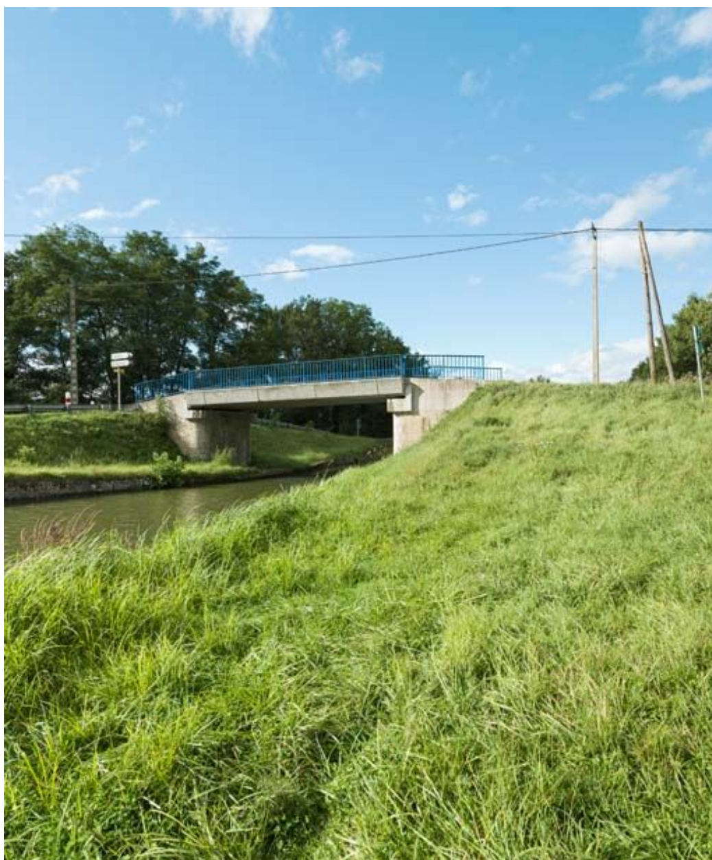
Vue d'ensemble du pont.
