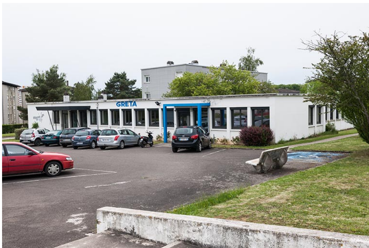
Locaux du GRETA.
