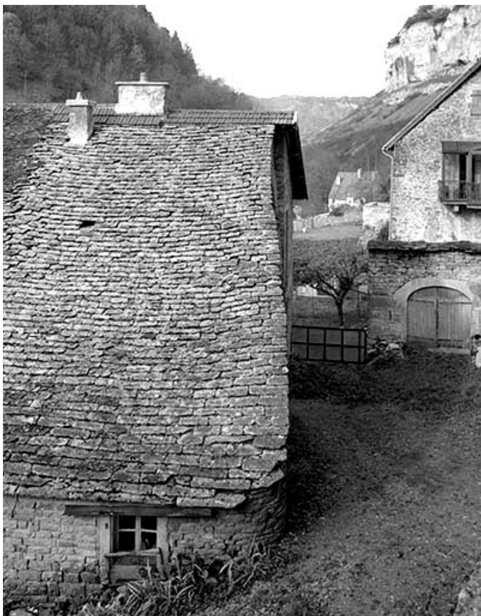
Détail d'une toiture en laves.
