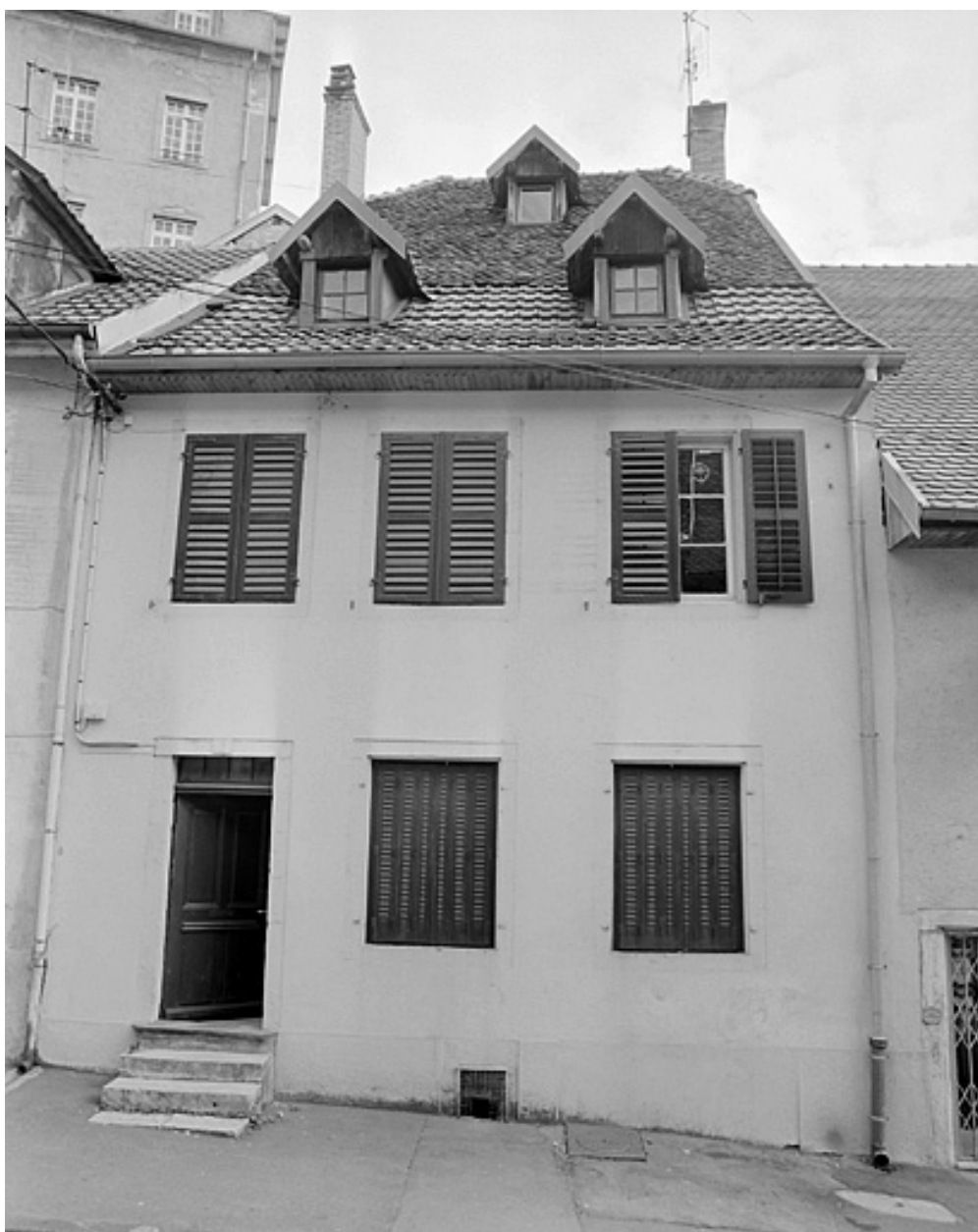
Façade sur rue du corps d'habitation.
