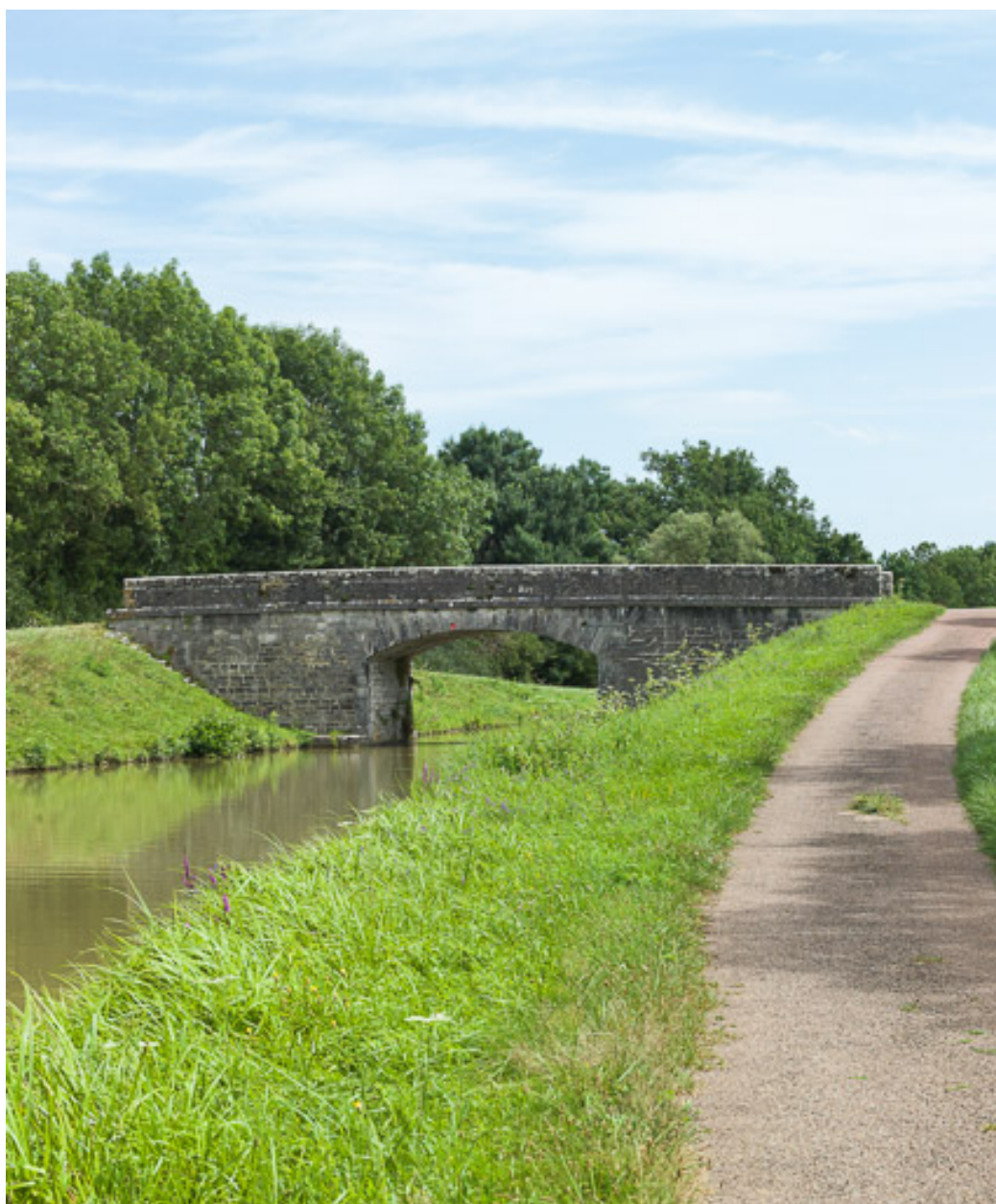
Vue d'ensemble du pont.
