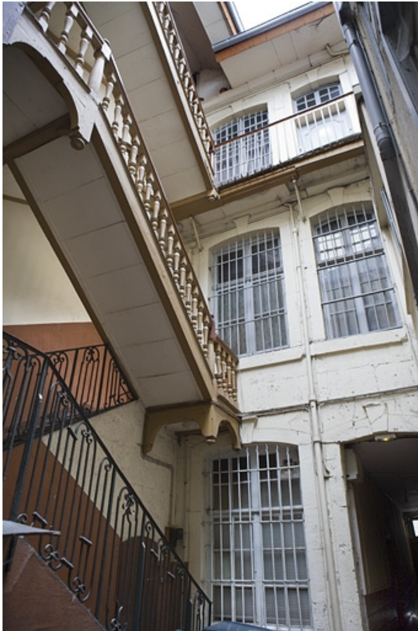
Façade postérieure du logis principal.
