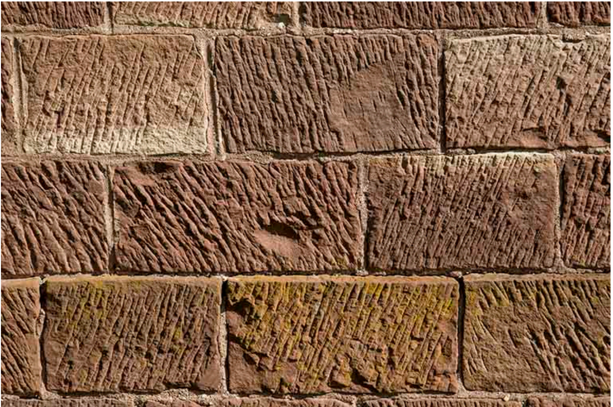
Grès des Vosges, gros oeuvre de la chapelle.
