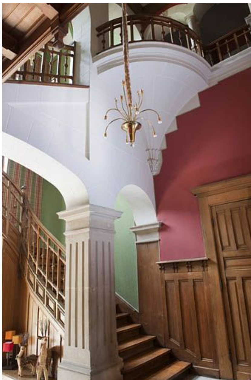
Cage d'escalier depuis le rez-de-chaussée.
