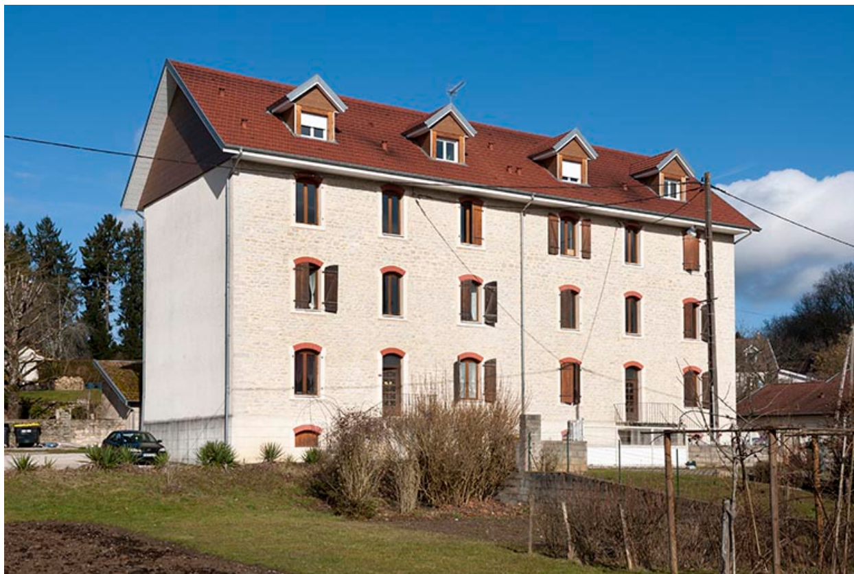
Immeuble de logements. Vue depuis le sud.
