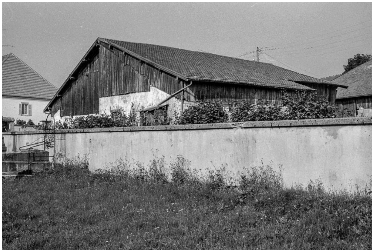
Ferme : façades postérieure et latérale droite.
