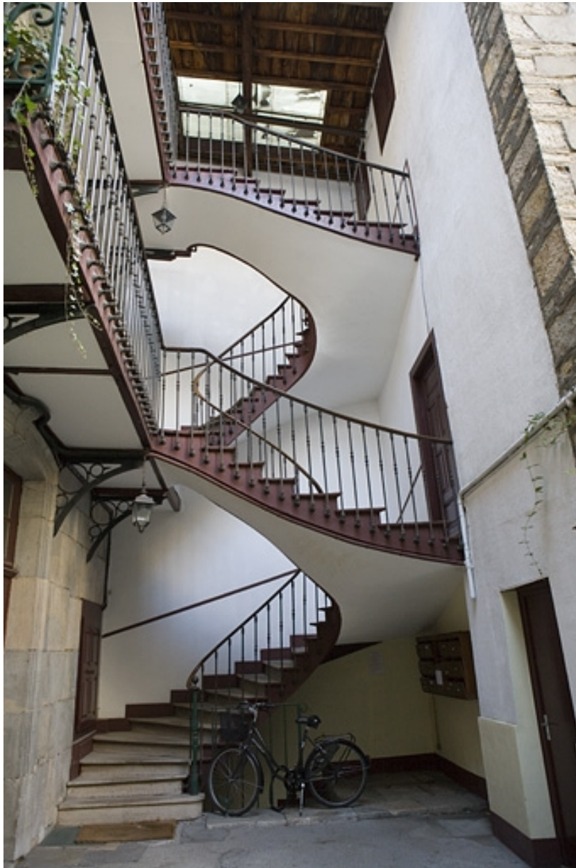
Détail de l'escalier à cage ouverte du logis principal.
