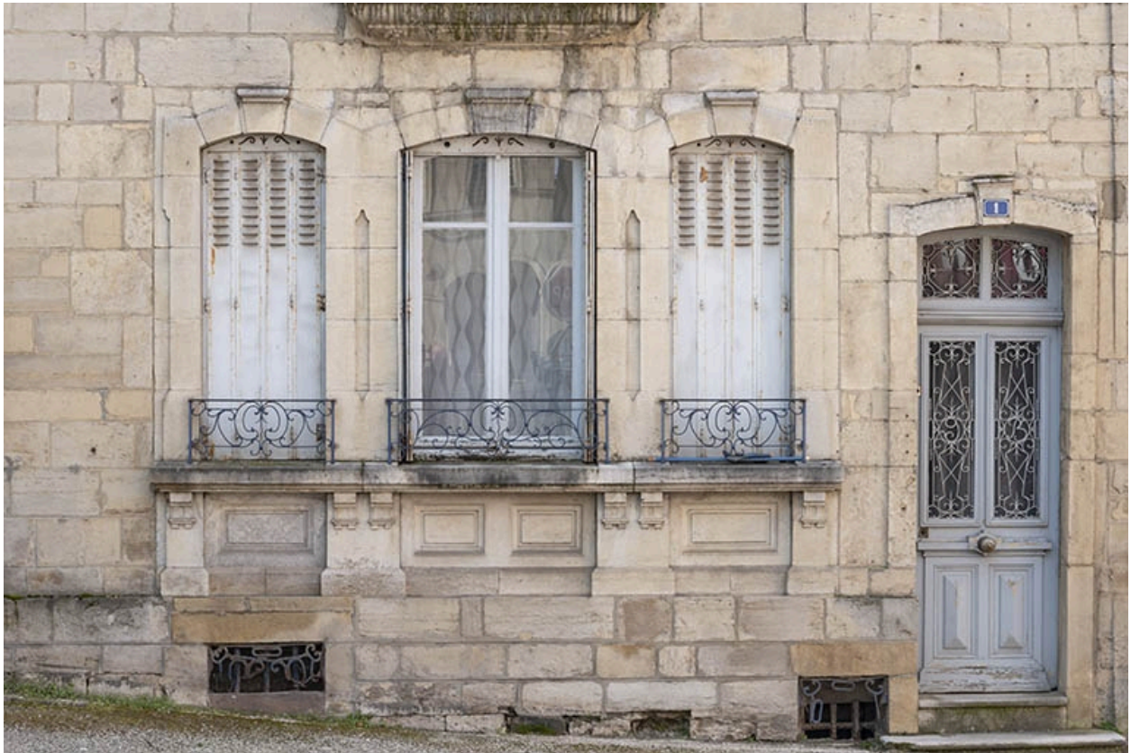
La rue Gambetta : n° 1, rez-de-chaussée.
