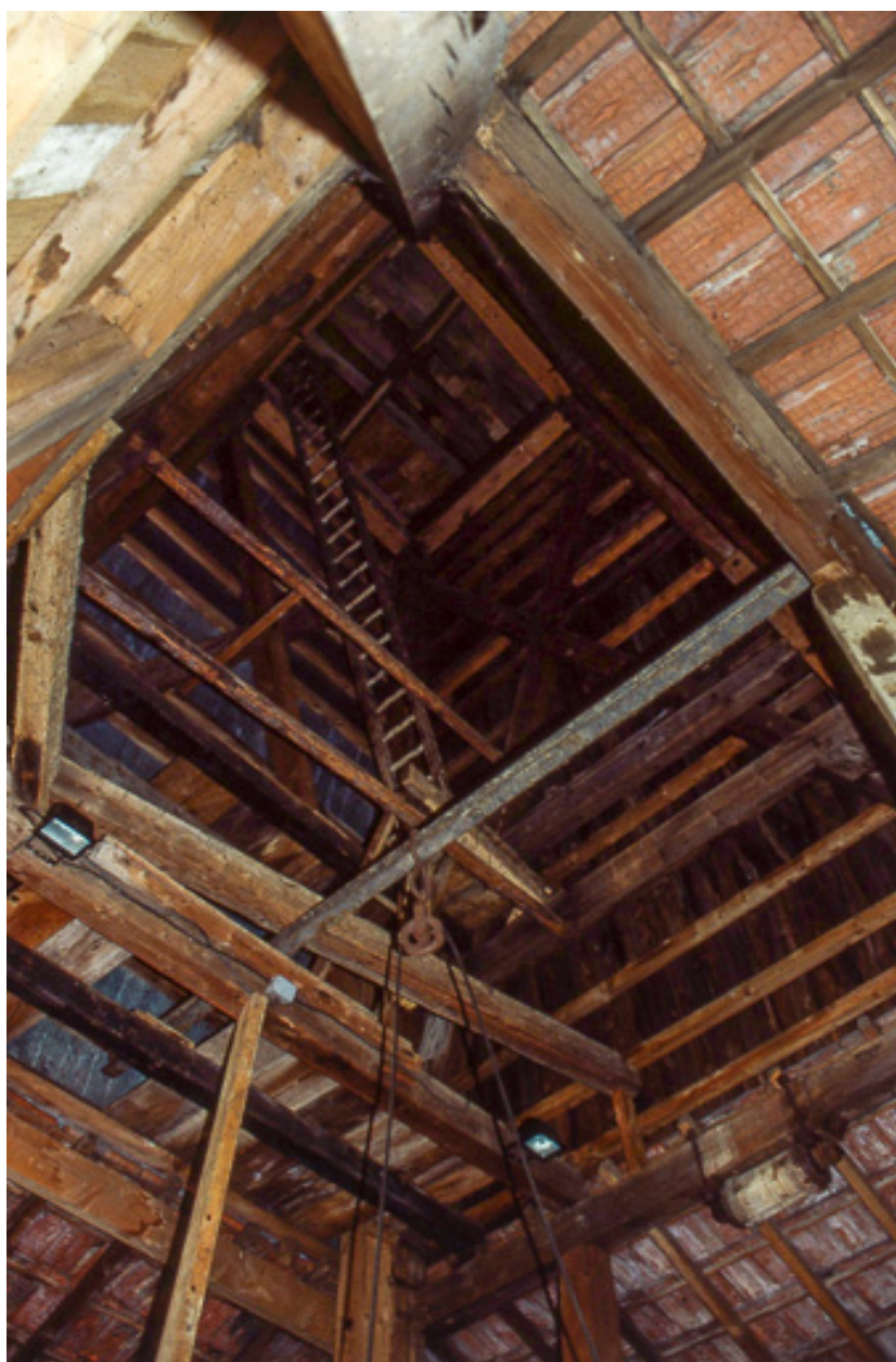
Puits de sondage nord : intérieur
