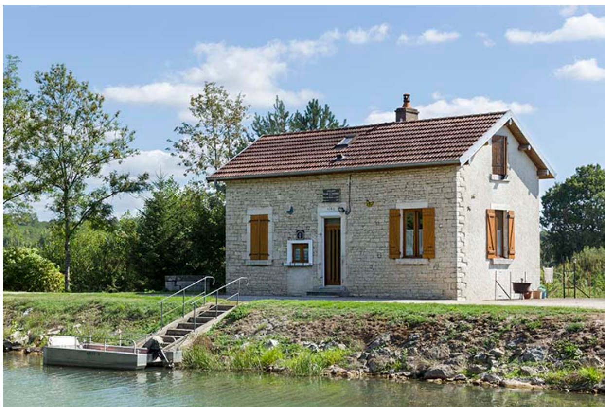
La maison de l'éclusier.
