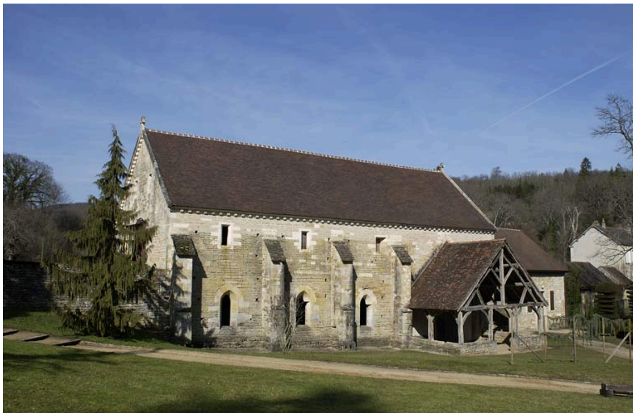
Cellier : élévation est.
