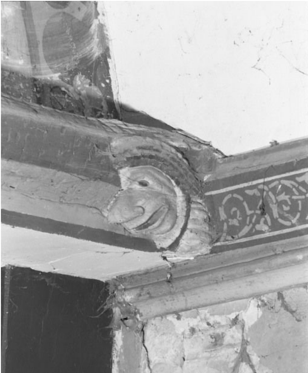
Charpente de la nef, extrémité droite du 5ème entrait
