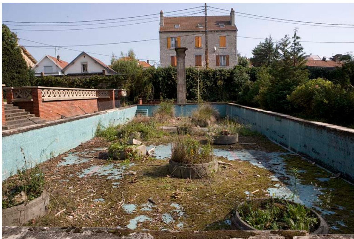
Piscine : le bassin à l'abandon.
