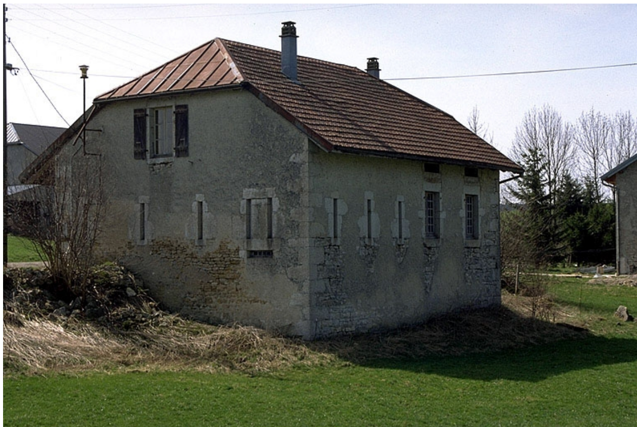
Façades postérieure et latérale gauche.
