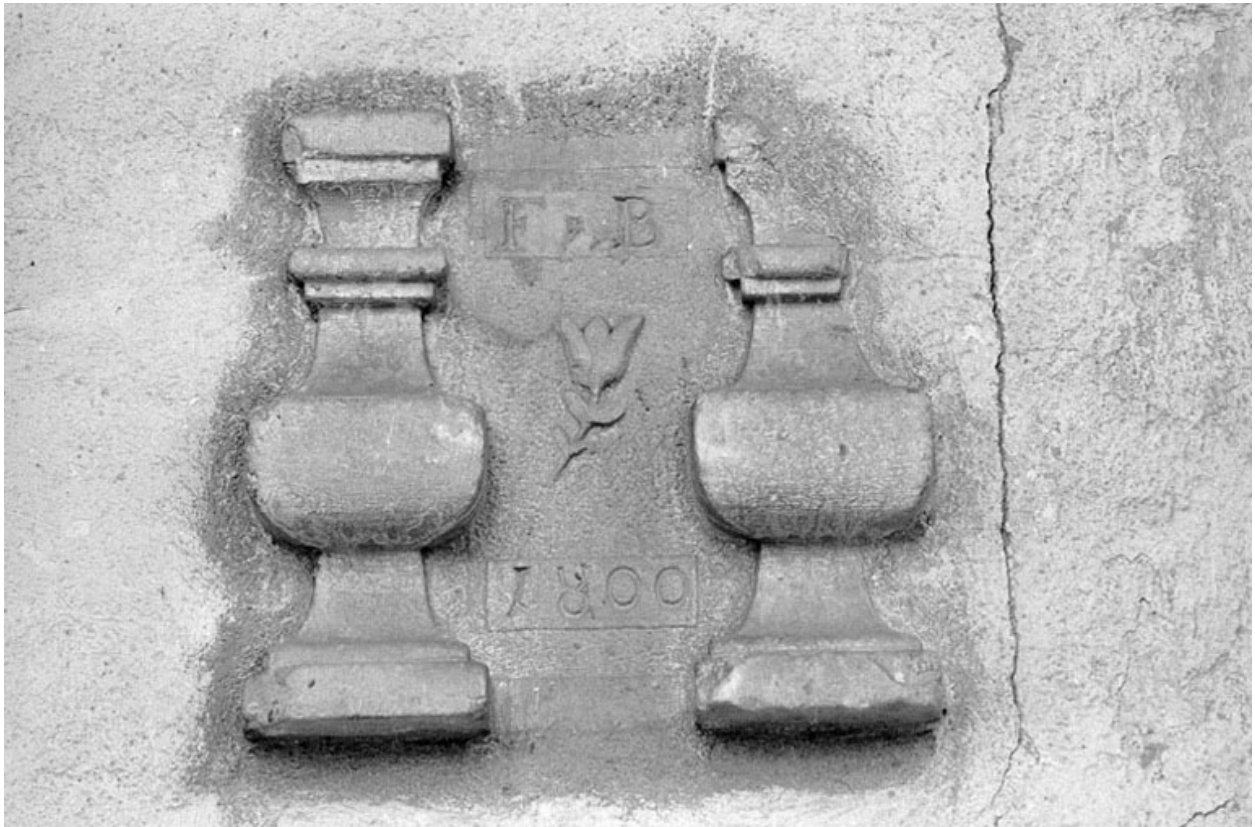
Pierre sculptée (remployée) sur le bâtiment de nettoyage et d'embouteillage en 1980.SRI. Enquête régionale sur les bâtiments industriels (1979-1981).
