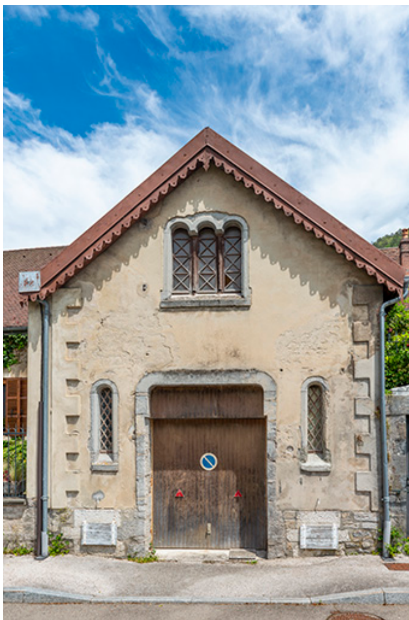
Remise nord (quai Valette).
