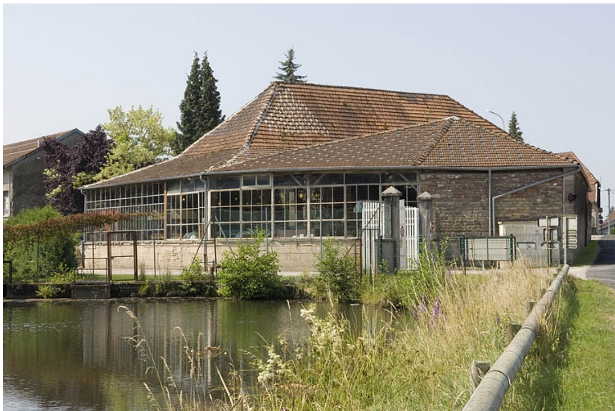
Ancien séchoir à bois depuis le nord-est.
