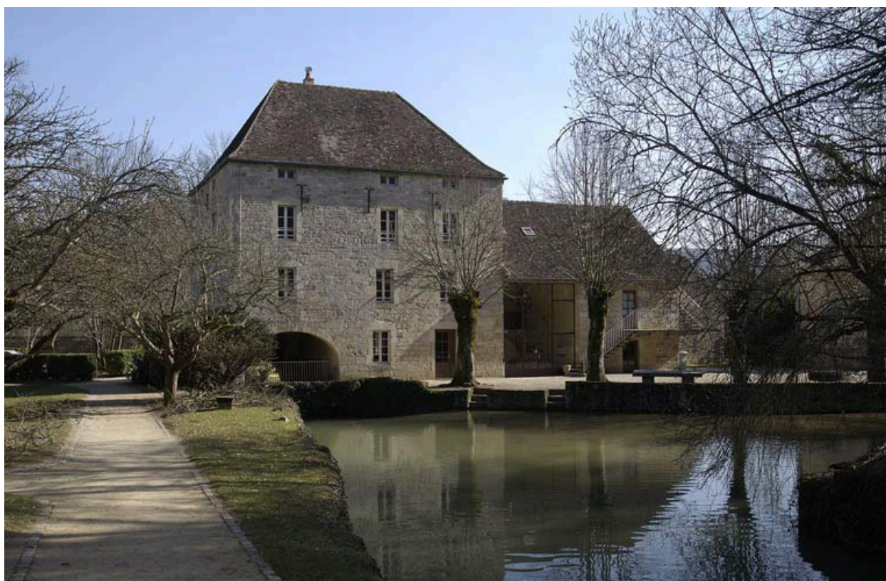
Ancien moulin à eau : élévation ouest.
