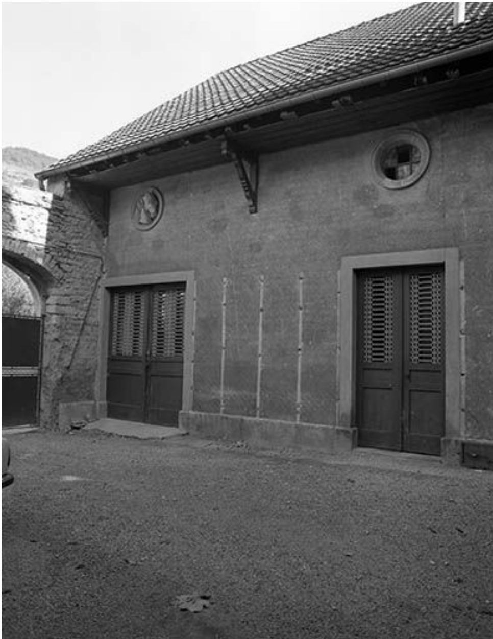
Façade antérieure de l'écurie.
