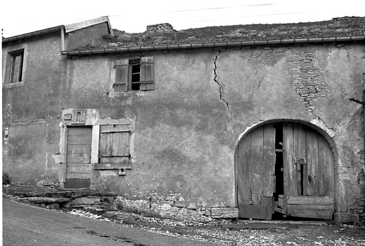
Maison située rue de l'Ormeau.
