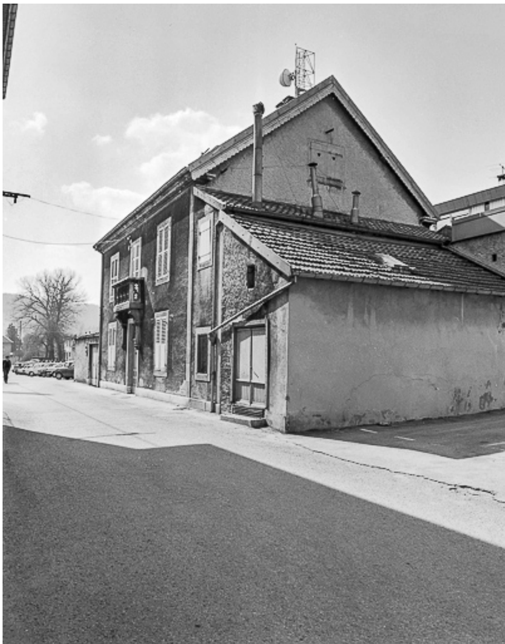
Façades sur rue et latérale droite.
