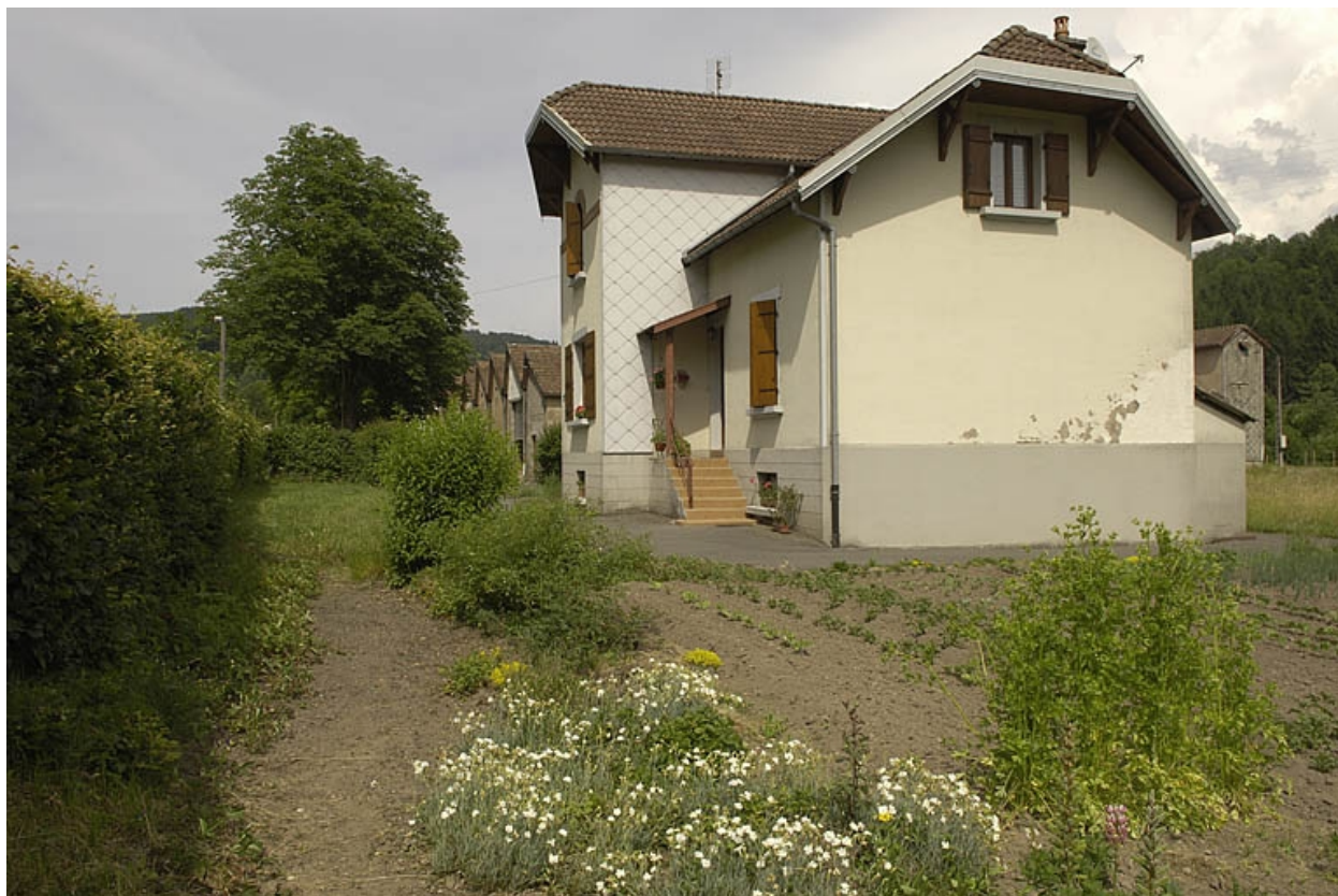
Logement de contremaître. Vue de trois quarts.
