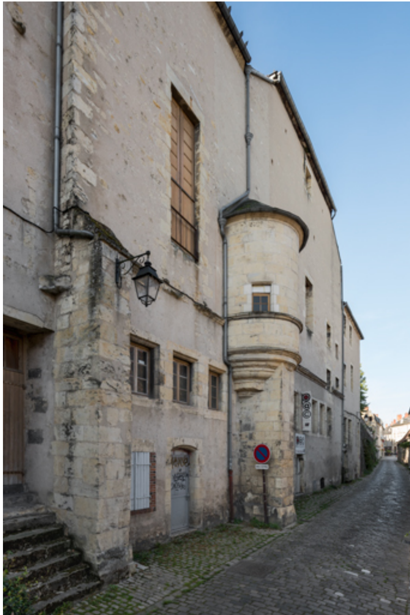
Façade postérieure, vue en enfilade.
