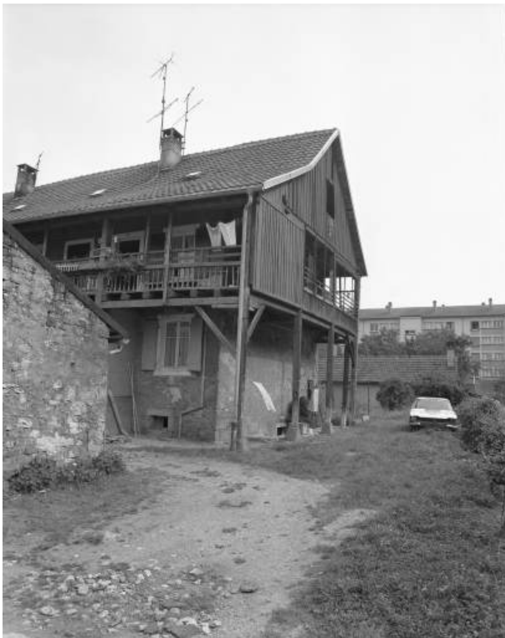
Pignon ouest en 1981.
