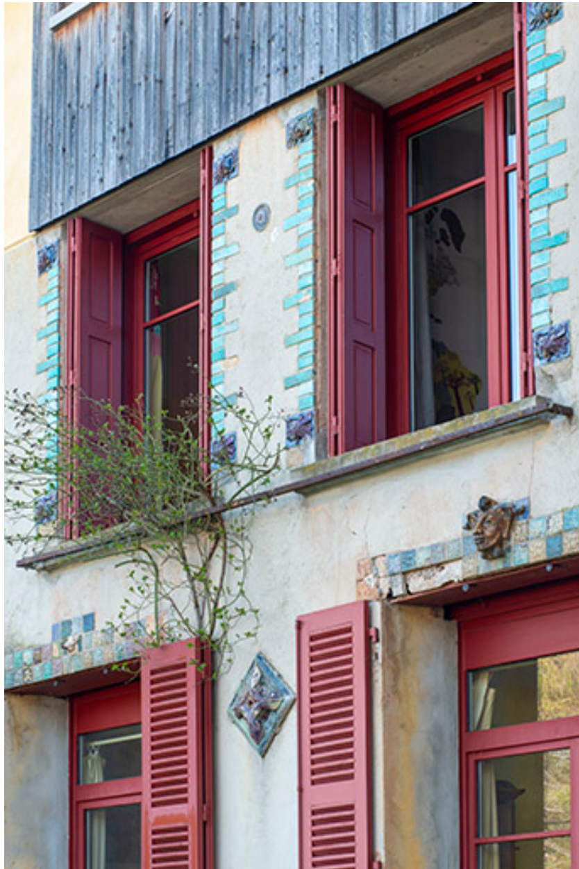
Mur pignon du logement sud. Détail du décor des baies.
