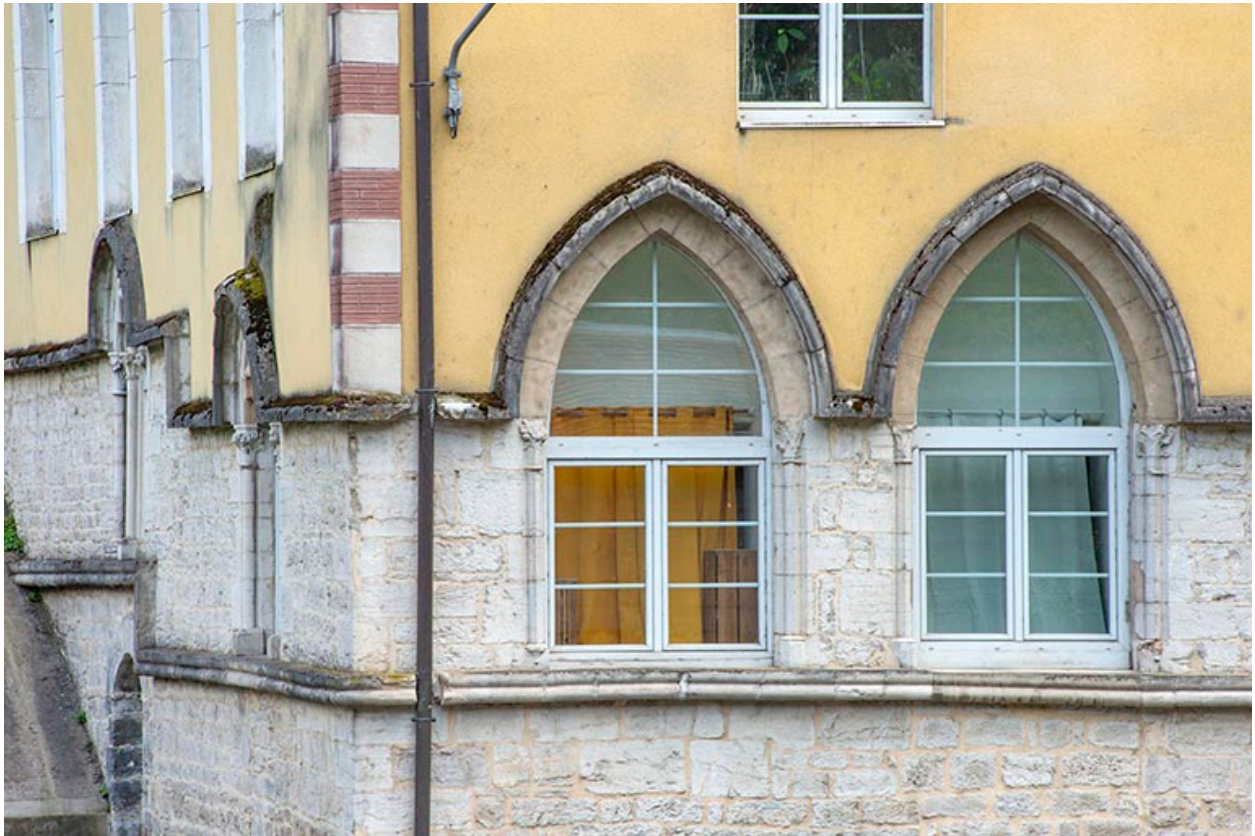
Fenêtres du premier étage, depuis l'ouest.
