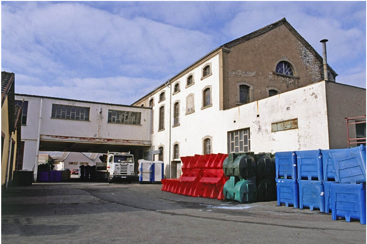
Façade postérieure des ateliers de fabrication.
