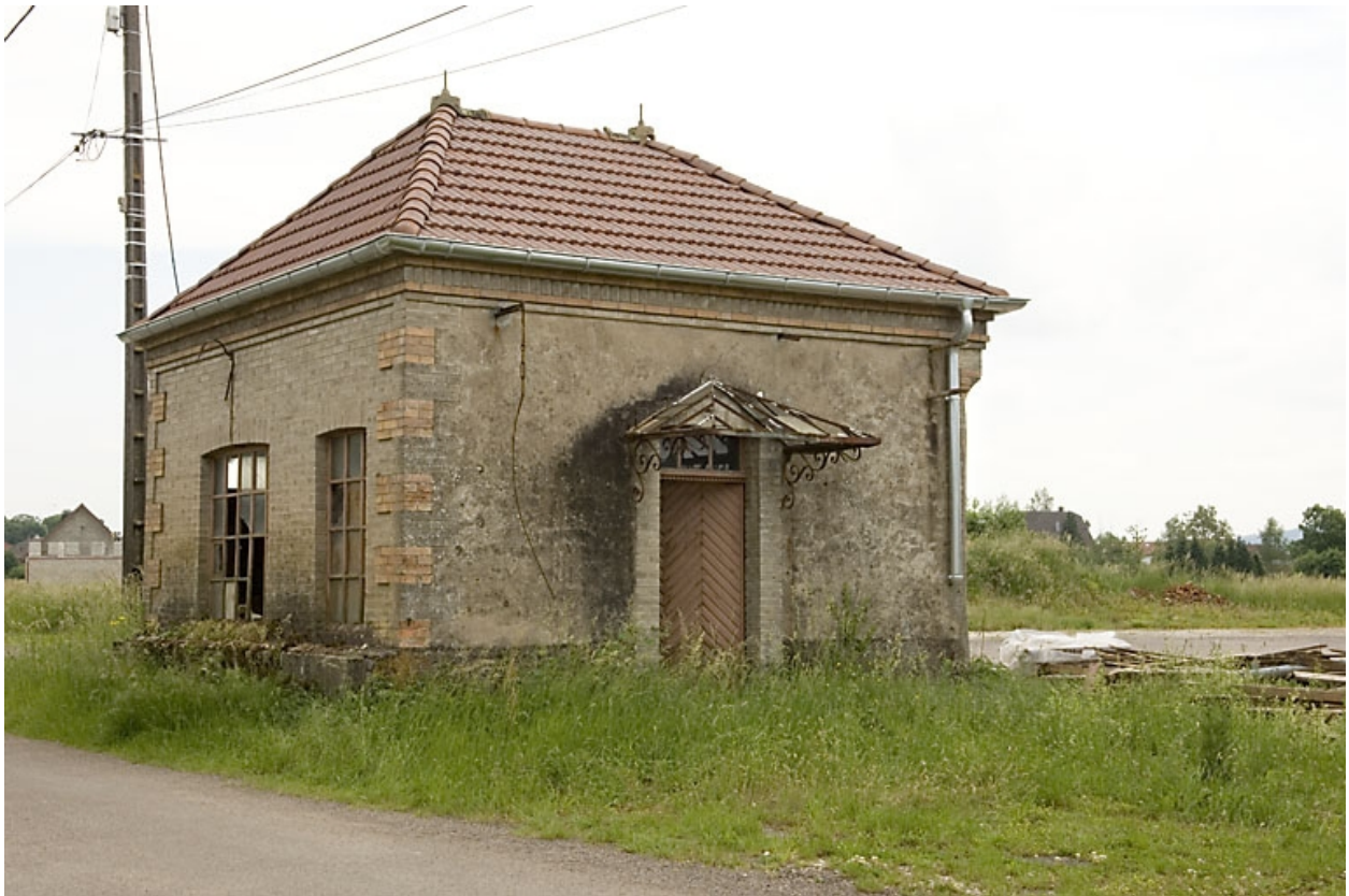
Local de la balance du pont bascule.
