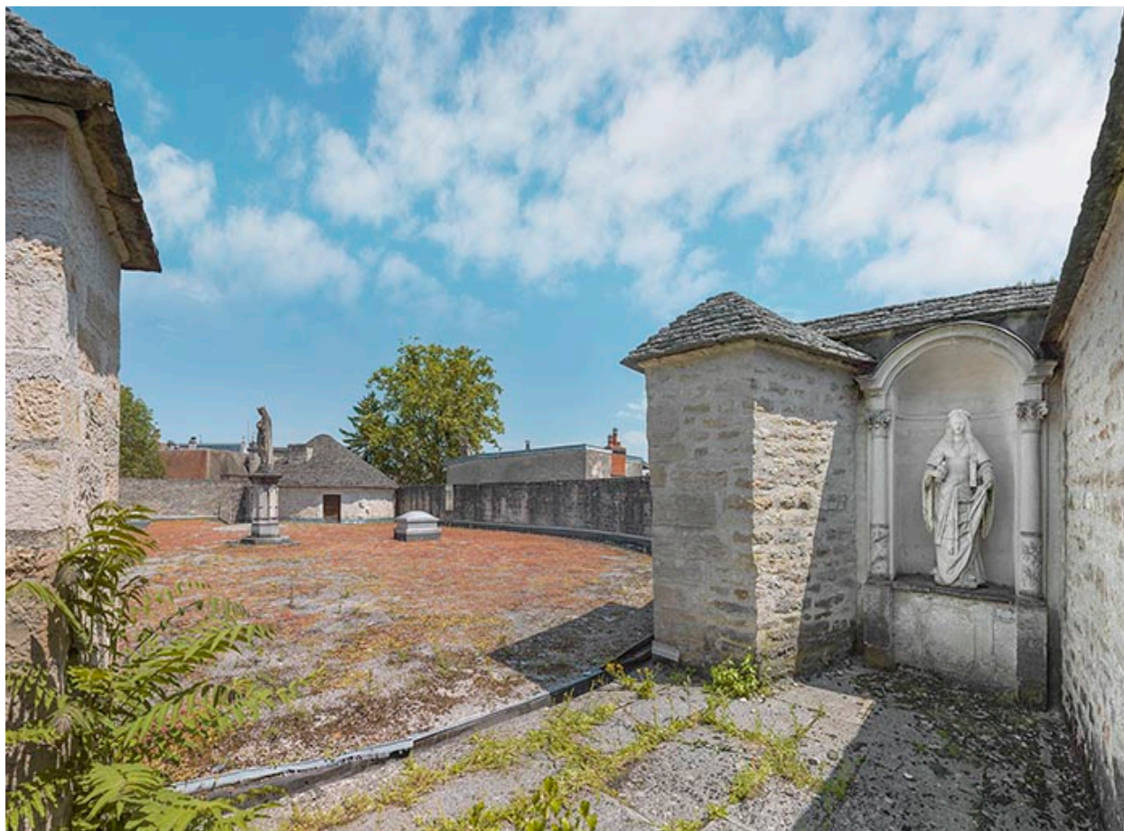
La plateforme supérieure de la tour.
