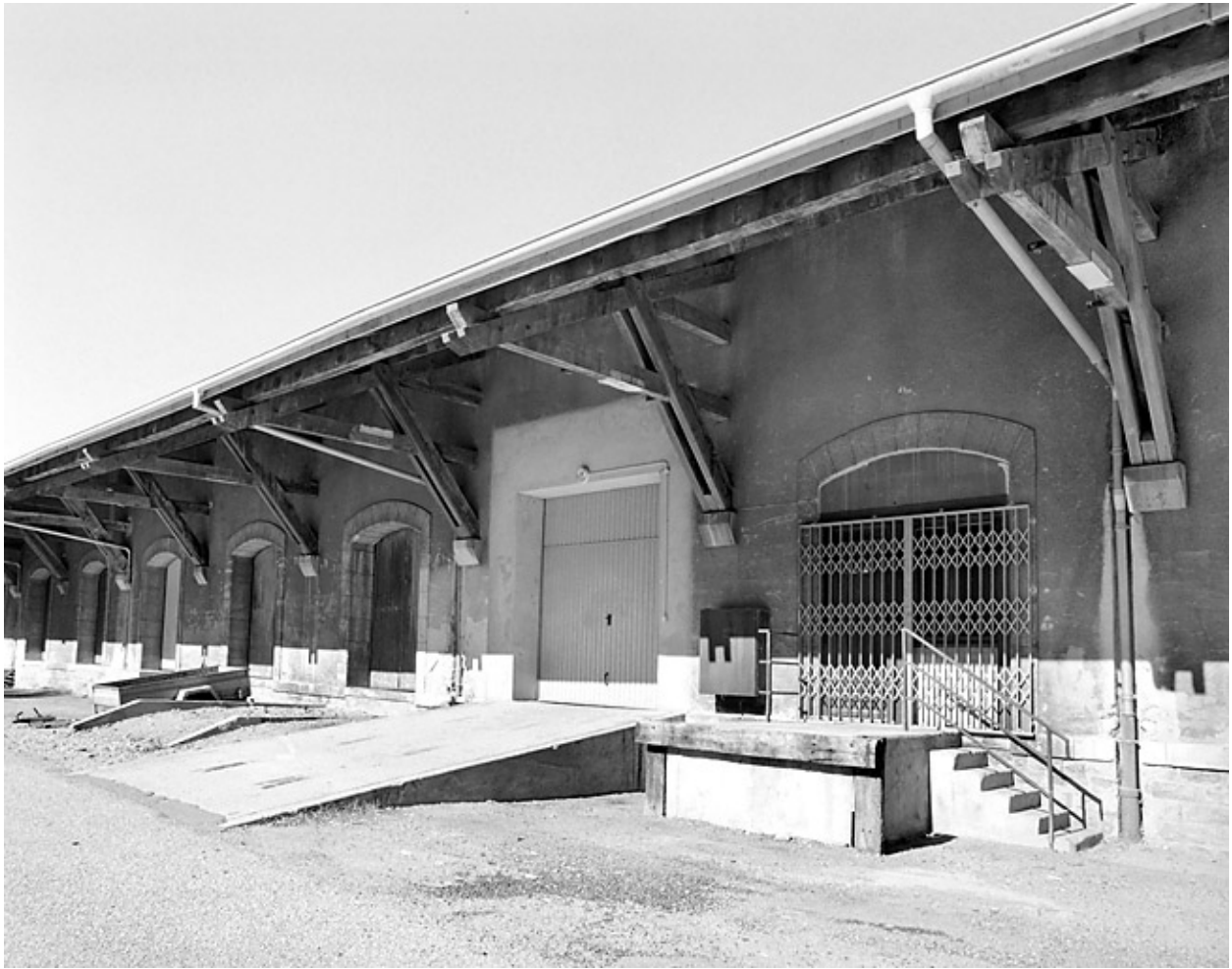
Entrepôt : façade antérieure.
