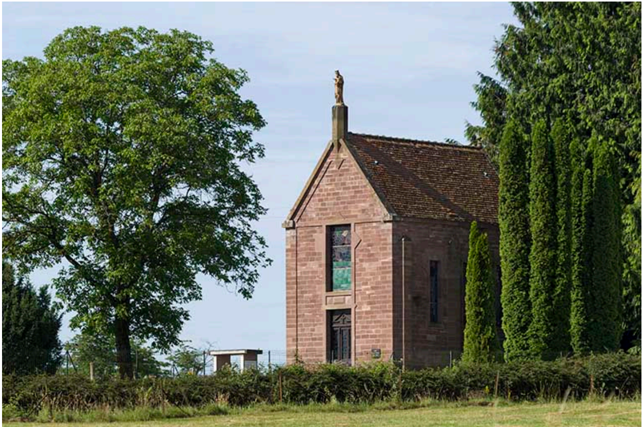
Façade principale de la chapelle.
